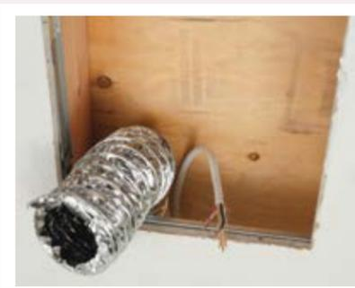
Support de montage rapide Flex-Z-Fast installé avec conduit et câblage existants
